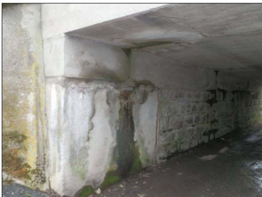
Obr. č. 5 - opěra Strakonice za pravý čelem, rozšíření pomocí betonu opadává a intenzivně prosakuje
