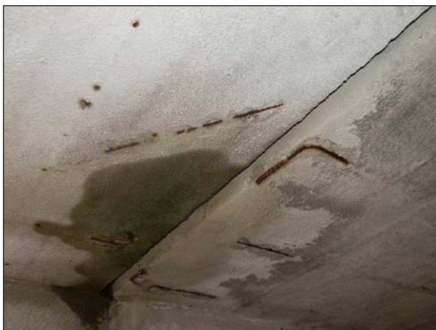
Obr. č. 9 - nosná konstrukce, průsaky dilatační spárou, koroze výztuže a opadaná krycí vrstva
