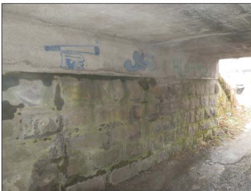
Obr. č. 7 - opěra Strakonice za levým čelem, pod prahem prosakuje voda
