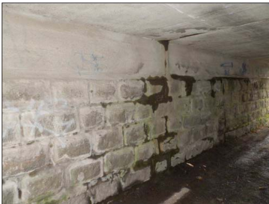
Obr. č. 6 - opěra Strakonice, střed objektu, dilatačními sparami a pod prahem zatéká
