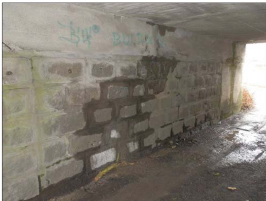
Obr. č. 8 - opěra Nepomuk za pravým čelem, dilatačními sparami pod prahem zatéká
