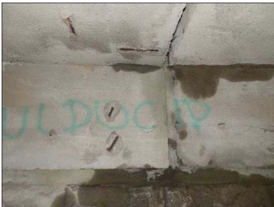
Obr. č. 9 - nosná konstrukce a opěra, průsaky dilatační spárou a pod prahem, koroze výztuže, opadání krycí vrstva
